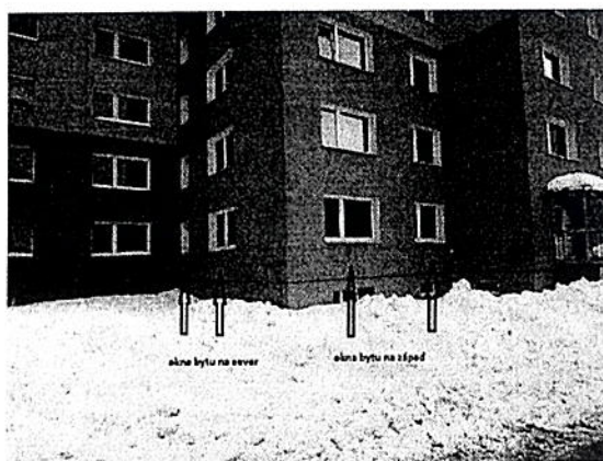
Severozápadní pohled na bytovou jednotku umístěnou ve zvýšeném přízemí – 1. NP
